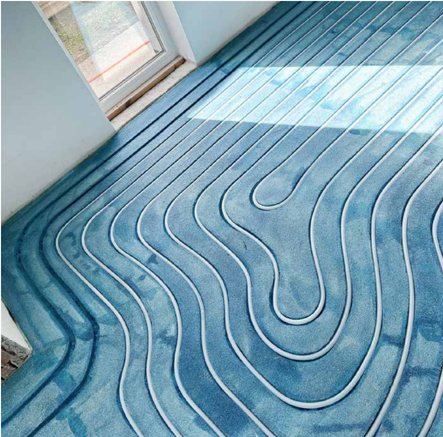
Sauber, schnell und kostengünstig: Komfort und warme Füße mit der nachträglich eingefrästen Fußbodenheizung
