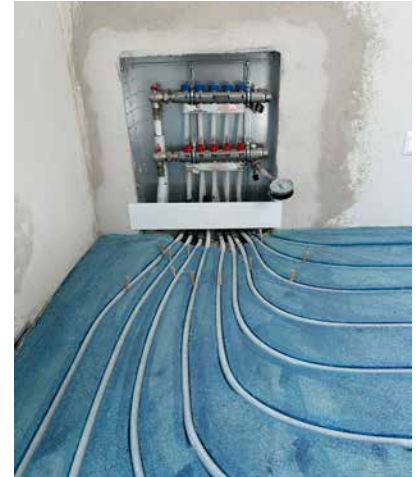
Sauber, schnell und kostengünstig: Komfort und warme Füße mit der nachträglich eingefrästen Fußbodenheizung
